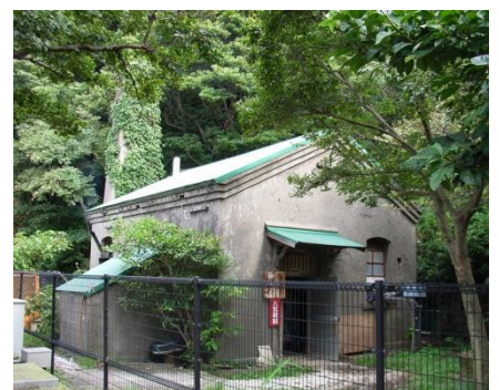
電気燈機関室 (煉瓦造平屋建)
