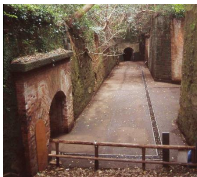
フランス積煉瓦の地下構造物
